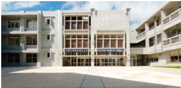
昇降口前庭から見る。強い日差しを遮るように、庇などは深く出ている。
