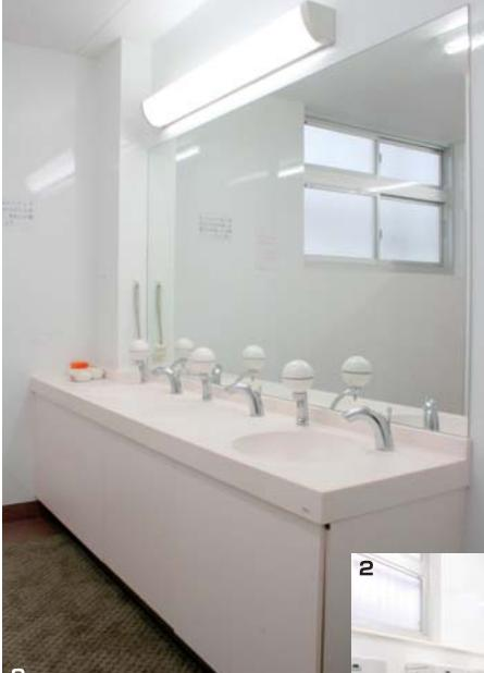
3. 節水と衛生面に配慮して、洗面コナーには自動水栓を採用。節水型の大便器・小便器と合わせて設置することで、節水効果はアップする。
