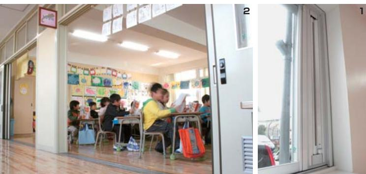
1. 窓の脇に換気スリットを設け、窓を閉めたまま換気を行えるように。夏は溜まった熱気を夜間に排出。
