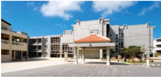
アプローチからみた全景。左端に見える体育館は既存。
