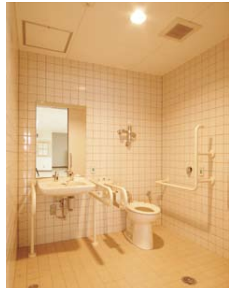
多目的トイレ。和洋便器とも床には大型タイルが敷かれて、清掃性をアップしている。
