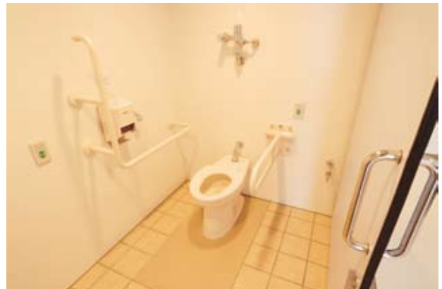
多目的トイレ。和洋便器とも床には大型タイルが敷かれて、清掃性をアップしている。
