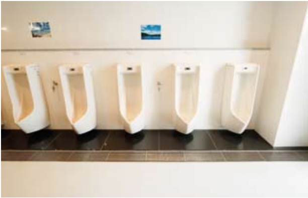
小便器のわきには水栓が設けられている。壁際からグレーチングまでがウェット清掃の範囲。通路部分はドライ清掃方式と区別されている。
