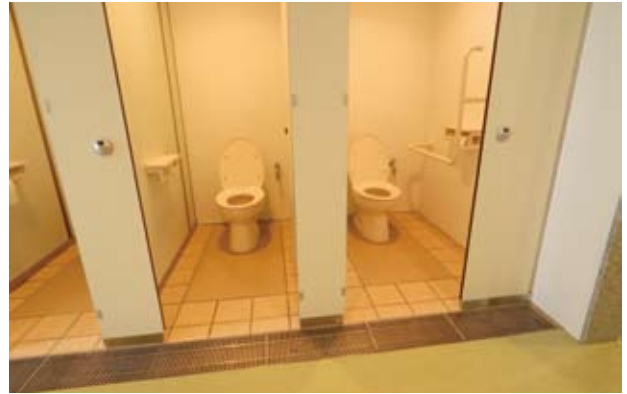
女子トイレに限らずブースの中には水栓が設けられた。
