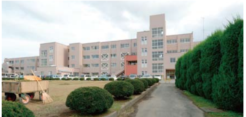
校舎全景。開口部に見えるブレースは耐震補強。校舎からトイレと階段室が突き出している。
