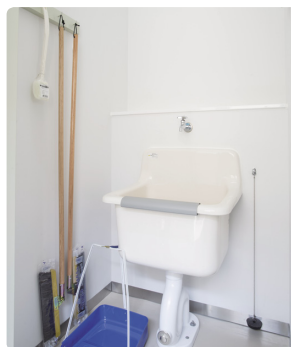
掃除用流しの横には、掃除道具収納用のハンガーがつけられている。
