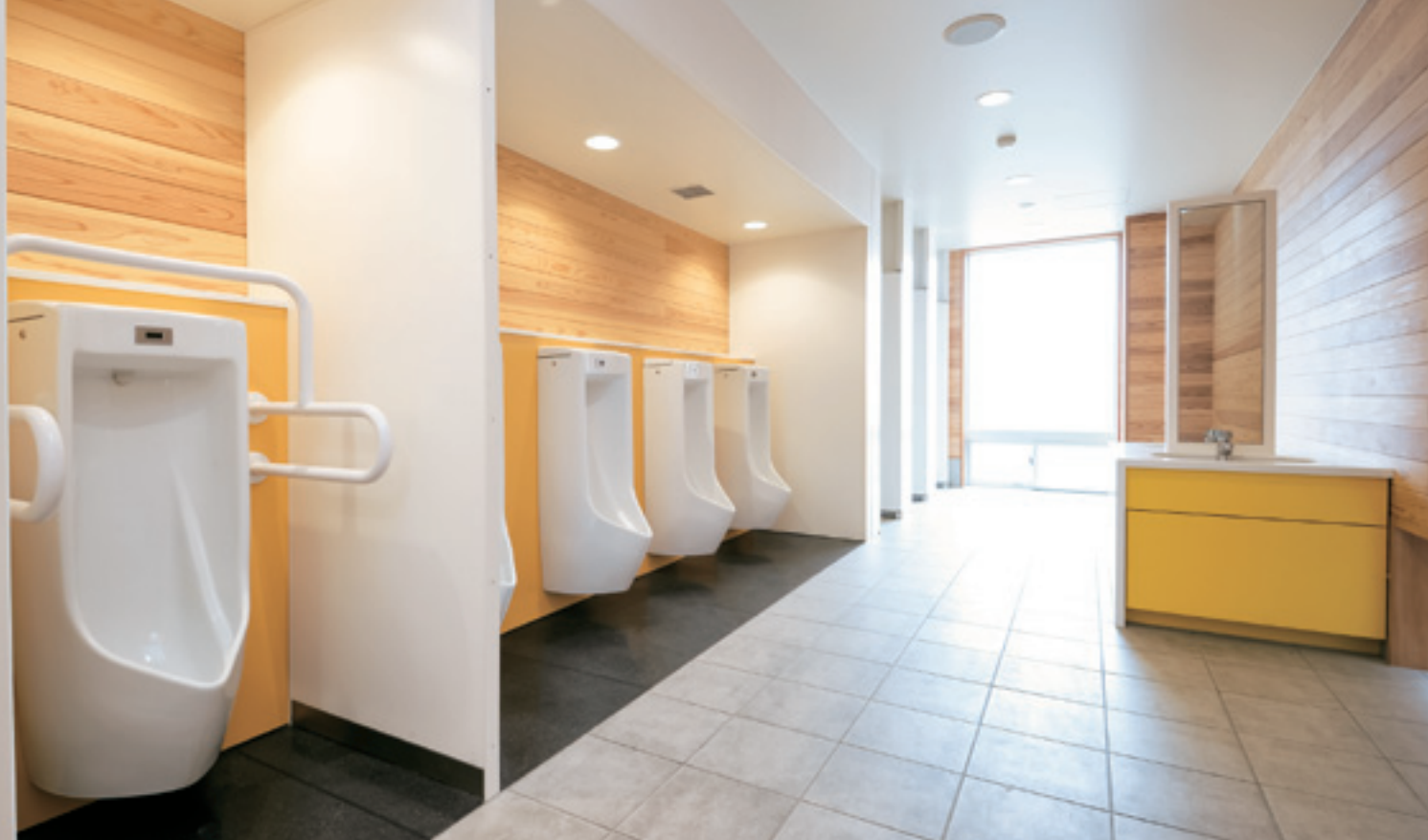
成長に合わせて高さを変えた小便器は、清掃性を配慮した壁掛け式。恥ずかしがる子には緩やかな仕切り板も。正面開口部以外に洗面台の足もとにも窓を設置。
