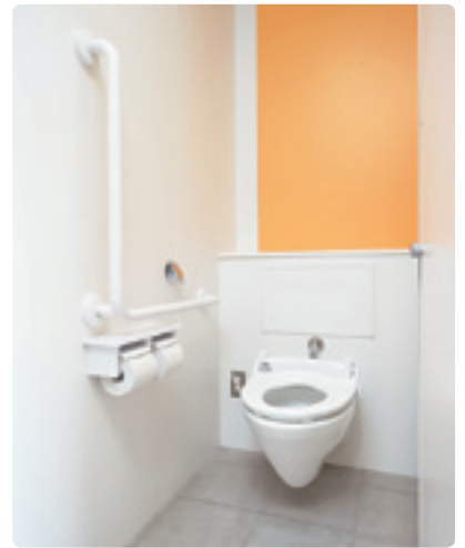
大便器も掃除がしやすいように壁掛け式を採用。新校舎ではすべて洋式便器となっている。
