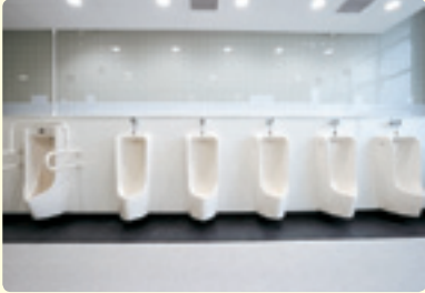
中学部の小便器の洗浄方式も自動洗浄からフラッシュバルブ式までさまざま。
