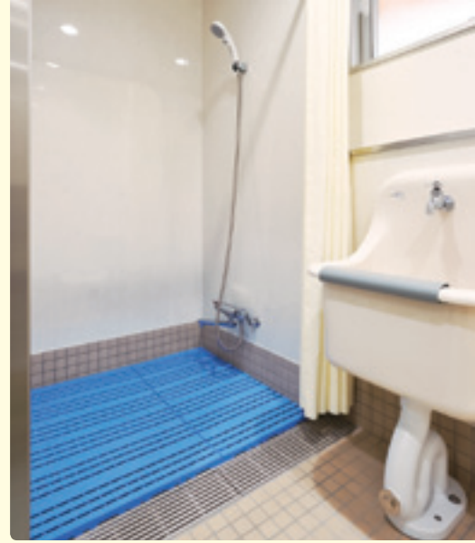
掃除用流しとシャワーは近くにあると、子どもの排せつ指導時に重宝する。壁はトイレと合わせ、浴室用メラミン不燃化粧板。
