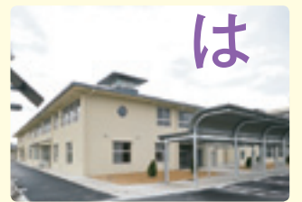
通学バスが停まる場所のすぐ目の前にもトイレを設置。
