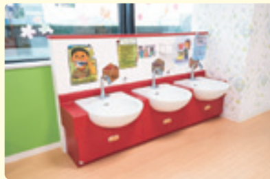
保育室の隅に設置された洗面台も成長に合わせて使いやすい高さに。
