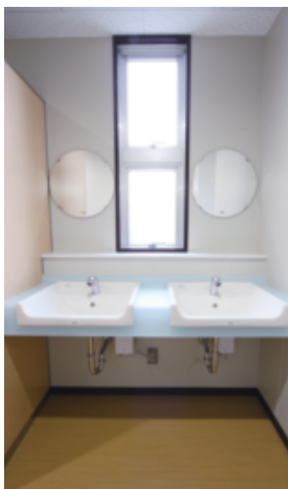
女性職員用トイレの洗面台には透明感のあるカウンターを採用。洗面器は水はねを低減するタイプに。
