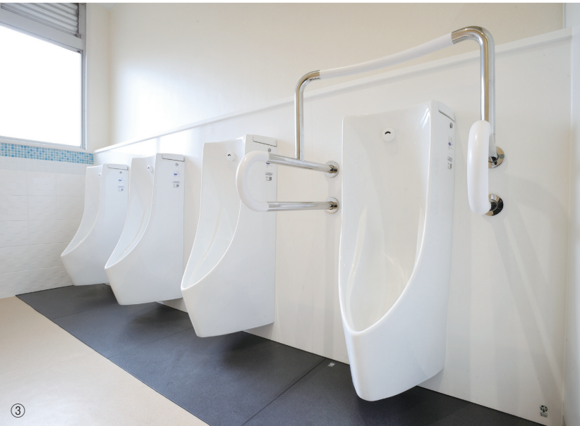
①男子トイレの個室ブースにつけたアークスライド方式の扉。「ぶら下がる子がいるのではと心配しましたが、問題なく使っています」(やまぞえ小学校中西正司校長 取材時) ②モザイクタイルや木材、塗材などさまざまな素材を使って表情豊かな空間に。③超節水タイプで掃除のしやすい壁掛小便器を採用(以上やまぞえ小学校)。
