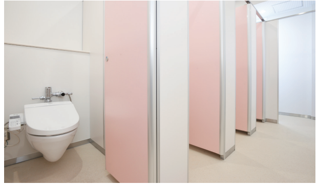
掃除がしやすいように壁掛式の便器に。ドアは緊急時には外側にも開く設計になっている。
