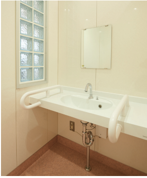
入り口付近の手洗い横壁はガラスブロックを取り入れ、気配が感じられるように。
