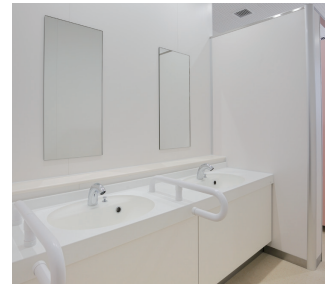
清潔に使える洗面ボウルとカウンターに継ぎ目がない一体型洗面台。
