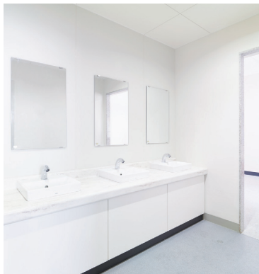
洗面コーナー。自動水栓タイプで非接触。
