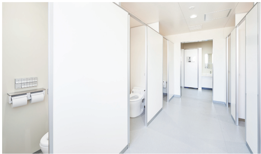
2階女子トイレ。ブースはすべて内開きに。使っていないトイレがすぐわかる。床は、メンテナンスを重視し、防汚&ノンワックスタイプのグレー色を選定。壁は明るくなるようホワイト系に。
