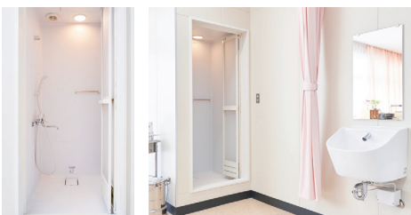
保健室にはシャワーと手洗いを設置。
