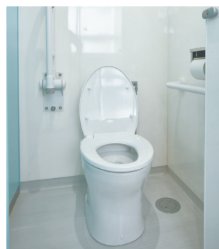
男子トイレのブース。ケガをした生徒が使いやすいように、一部には手すりをつけて。
