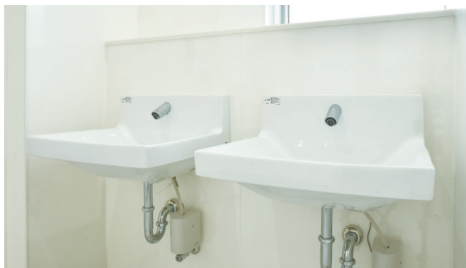
女子トイレの洗面コーナー。水栓の取付面が汚れにくい壁付タイプの自動水栓を採用。
