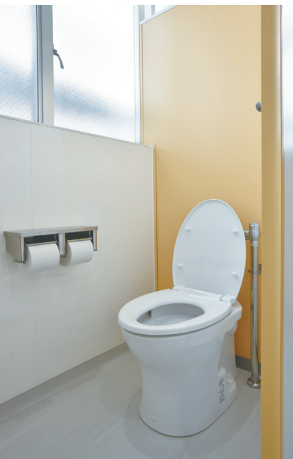
横壁一面がアクセントカラーになった女子トイレのブース。床材を立ち上げ、掃除がしやすくなっている。
