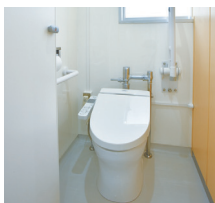
女子職員用トイレ。温水洗
