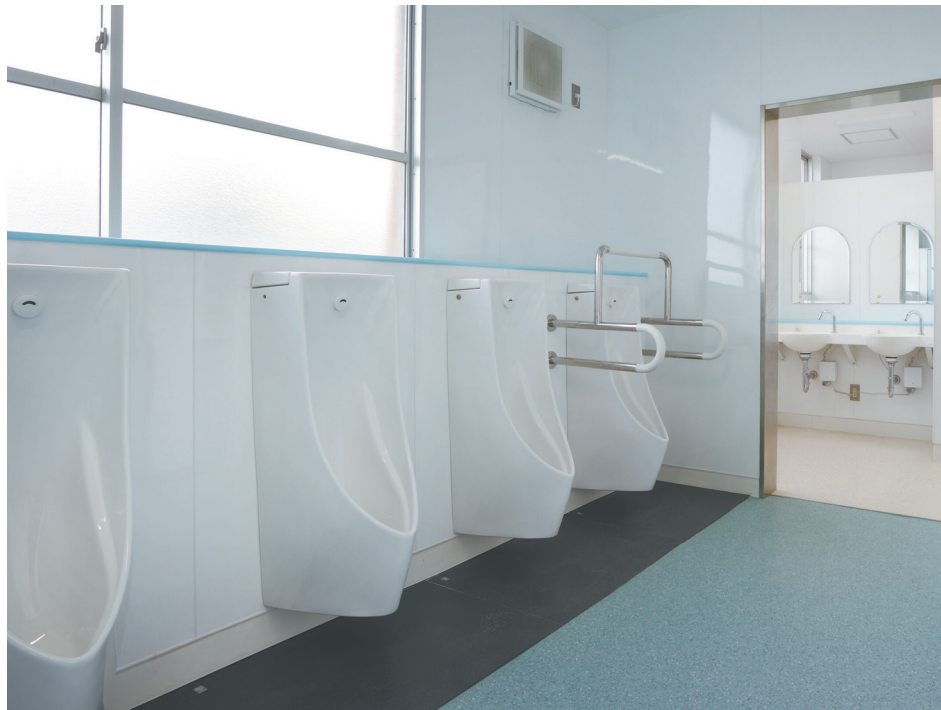
掃除がしやすいように小便器は壁掛け式に。小便器のすぐ下の床には、防汚性に優れた素材を採用。
