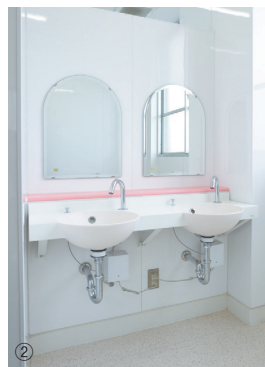
①洋式便器となり、掃除もしやすい。②女子トイレ内の洗面コーナー。感染症対策として非接触の自動水栓に。角が丸いミラーで温かみのある空間に。③職員用男子トイレのドアは、中が見えないように小窓にフェルトをあしらって。
