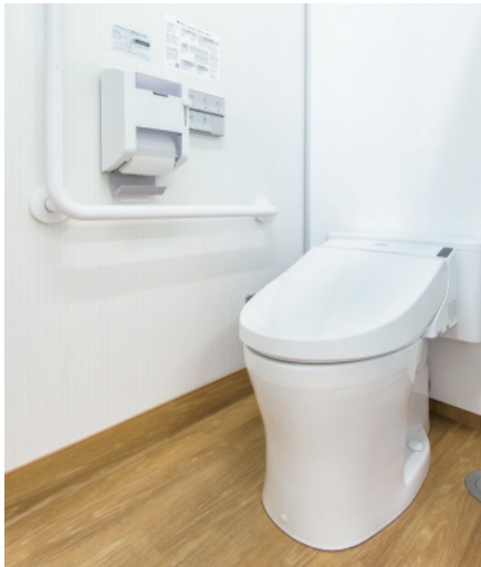
4F男子トイレのブース。大便器にはすべて温水洗浄便座を設置。操作パネルは電池交換不要タイプのリモコンに。
