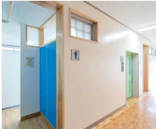
1Fトイレの入り口。クランクで仕切られているため中は見えないが、天井付近の壁を開けていることで開放的な雰囲気もある。
