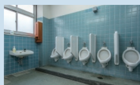
まだ改修の済んでいない西側1F女子トイレ(上)と、西側2F男子トイレ(下)。
