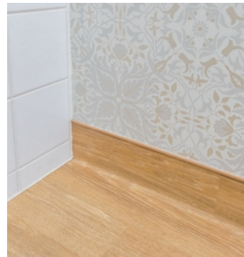
2F職員トイレ内。壁のクロス側は清掃性に配慮して床材を立ち上げている。
