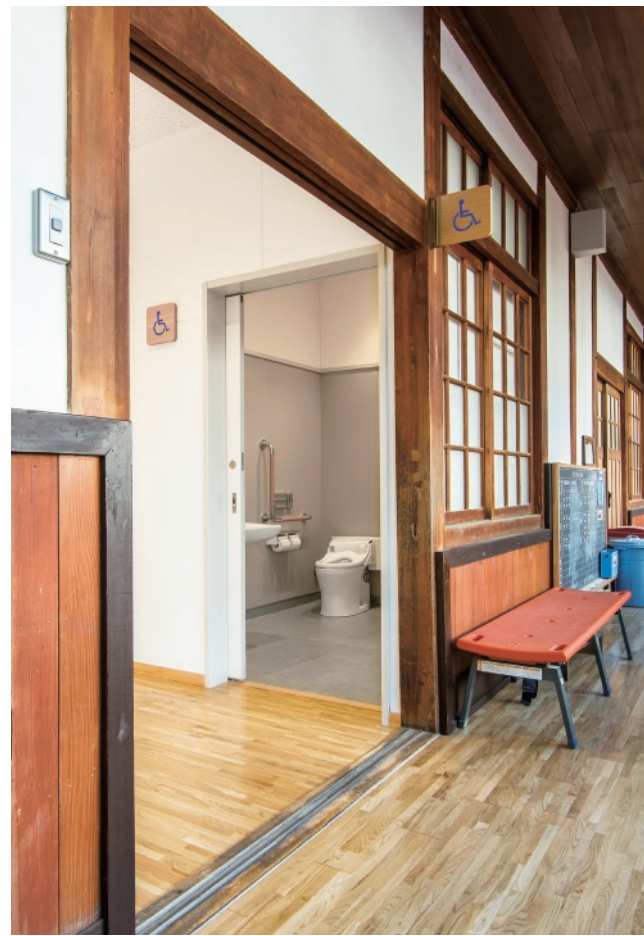
中棟1Fに設置した多機能トイレ。更衣室につながる前室があり、落ち着いて利用できる。
