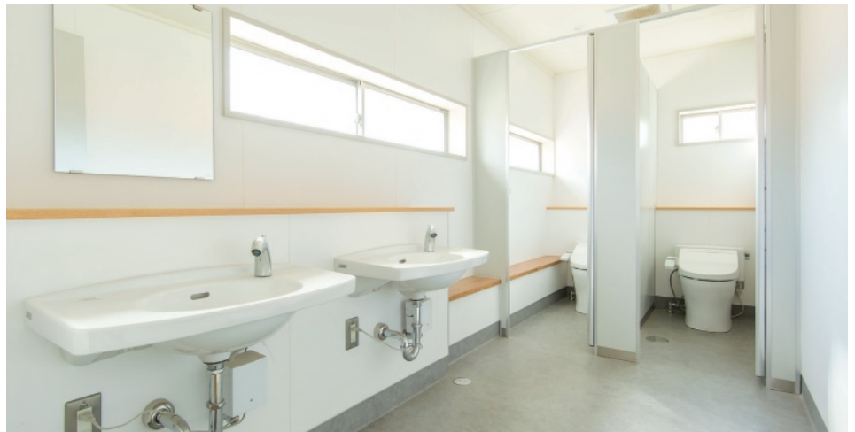
南棟1F東側の男子トイレ。安心して大便ができるよう小便器をなくして個室化。奥のベンチは、改修前は基礎だった部分を利用して設置。
