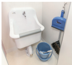
1F女子トイレ内の清掃用具入れ。1Fは男女別だが、他フロアはスペース確保のため、女子トイレの入り口付近にのみ設置。
