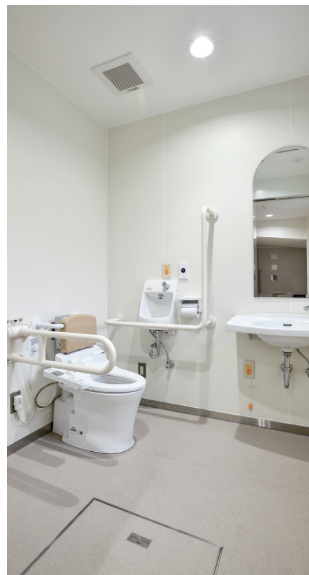
体育館は地域開放でも使われている。車いすの方も来校するので体育館にも多機能トイレを設置。
