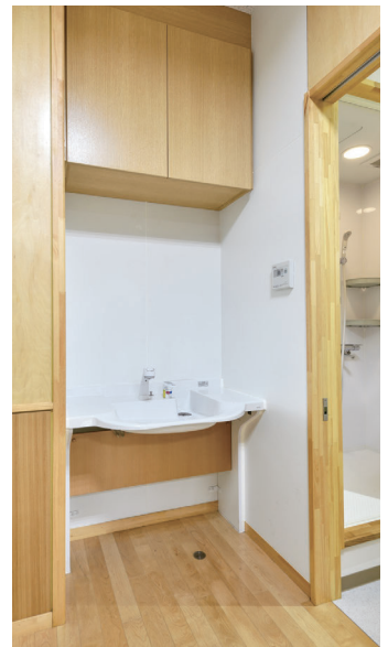
特別支援教室には、現場の要望を受け、手洗いの他にシャワーを設置(写真右奥)。入学したてで排泄後のお尻ふきが自分でできない子に備えている。
