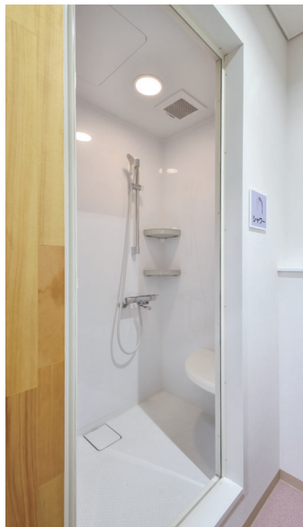
保健室内のシャワーブースは、室内に腰かけつき。けがをした児童は座りながらシャワーを使うことも可能。
