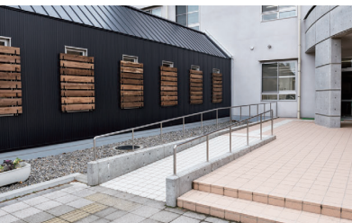
玄関へのアプローチにスロープを設けたり、校内にはエレベーターも設置するなど、建物全体がバリアフリーになっている。
