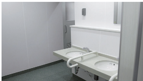
本棟1F女子トイレの洗面コーナー。自動水栓を採用した。奥に見えるドアの先は男女共有の洗面台があるトイレ前室。
