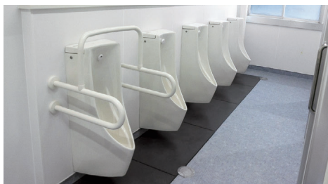
本棟2F男子トイレ。小便器は自動洗浄。足元の床には汚れや臭いなどの抑制効果が高い汚だれ石を採用。
