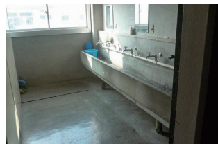
第2棟女子トイレ。長流しは昔ながらのハンドル水栓だった。
