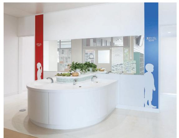
1F男女共用洗面コーナー。廊下と手洗いが一体となるスペースは曲面配置でコミュニケーションがしやすい。感染症対策と節水の観点からすべて自動水栓(自己発電式)としている。
