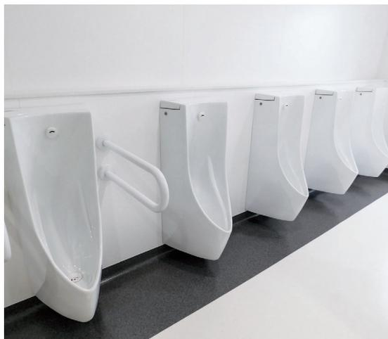
2F男子トイレ。壁掛け式自動洗浄小便器を採用。自己発電式で停電時にも使えるように配慮した。
