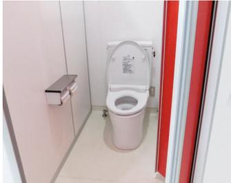
1F女子トイレ。最上階は校舎屋上受水槽からの水圧が低いため、一律タンク式を採用。
