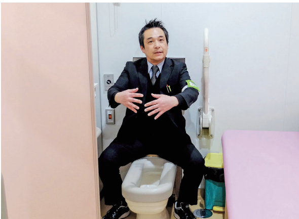
自分で体を支えられない児童・生徒の場合、倒れないように介助者が後ろから抱きかかえる。そのため大便器の後ろに、介助者が座るいすを造作で設置(右写真参照)。
