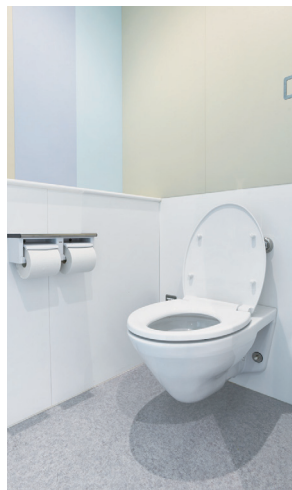
2階女子トイレのブース。壁掛大便器を選定し、掃除のしやすさに配慮。
