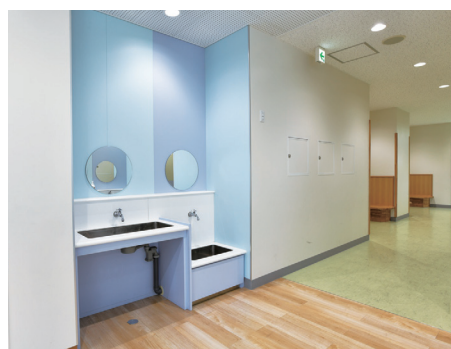
廊下に面した流し。流しの下は十分な空間があり、車いすでも使いやすい。
