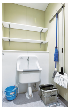
清掃用具入れには掃除用流しを設置。モップ掛けや棚が充実し、整理整頓しやすい。
