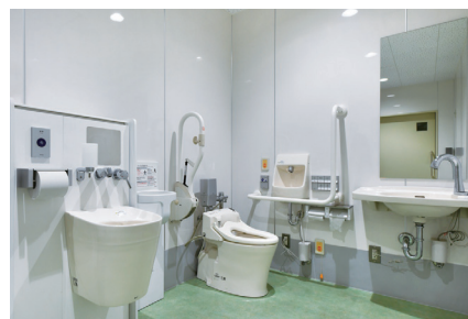
1階みんなのトイレ。市立小中学校ごとに1カ所設置。ベビーチェア、オストメイト対応設備などが完備。
