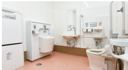
1階みんなのトイレ。オストメイト対応設備に加え、ペーパーチェアやおむつ交換用の設備も設けられている。
