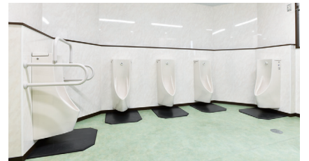
2階男子トイレ。衛生性、清掃性を高めるため、壁掛け小便器を採用。床には、防汚性の高い汚垂石を設置。
