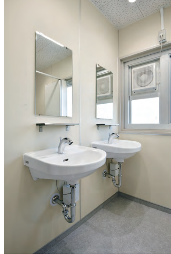
駒西小学校の女子手洗い。大井西中学校同様、自己発電タイプの自動水栓を採用。限られたスペースながら、手洗い場の数もなるべく確保した。
