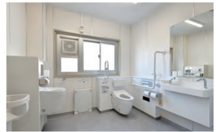
バリアフリートイレ。広々とした空間にはオストメイト対応設備やベビーチェアを備えた。手洗い場も、なるべく大きくゆったりと設計。
