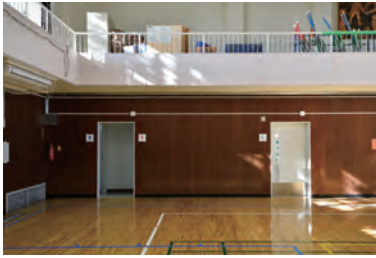
男女別トイレと、バリアフリートイレの入り口。サインをなるべく大きく配置し、初めて訪れた人がトイレの選択に困らないよう配慮。
