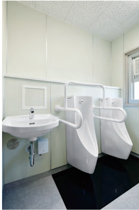
男子小便器は、床の清掃性に優れた低リップタイプの壁掛自動洗浄小便器。
