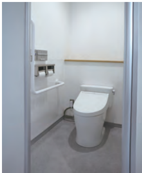
3階男子トイレ。小便器下の床には防汚性の高い汚垂れ石を設置。大便器はすべて温水洗浄便座を採用。
