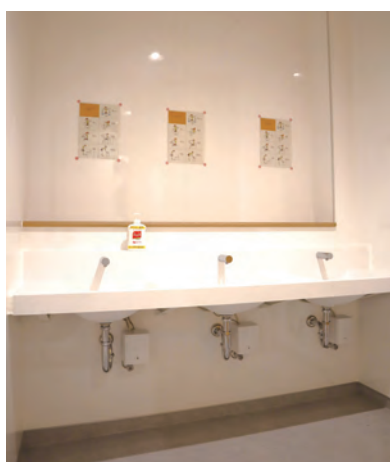
2階女子トイレ。手洗いは水仕舞いがよい壁付タイプの自動水栓を採用。
