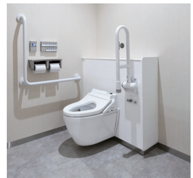
3階分散型女子トイレ内広め個室。けがをしたときを想定し、手すりを設けた。
