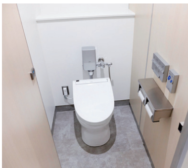
男子トイレ。校舎内の大便器はすべて温水洗浄便座と発電タイプの電波式リモコン。
