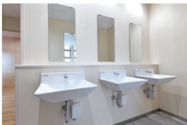
3階集中型女子トイレ内手洗いスペース。発電タイプの自動水栓を採用。
