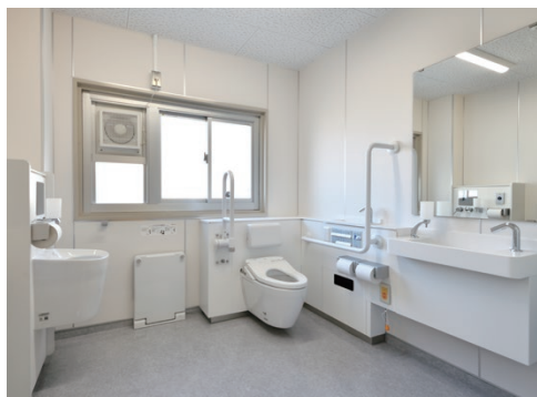
体育館トイレ (ふじみ野市立駒西小学校)
