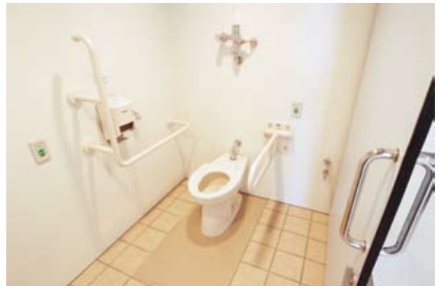
多目的トイレ。和洋便器とも床には大型タイルが敷かれて、清掃性をアップしている。
