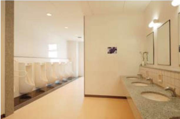
男子トイレ。男女とも以前のトイレの壁面はシックな黒いタイル張りであったが、明るいトイレとなった。
