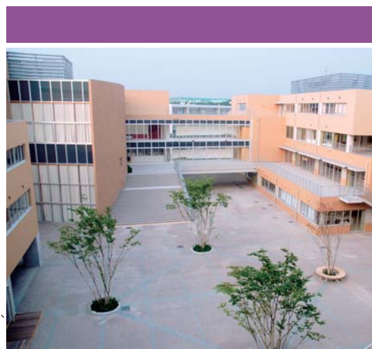
屋上緑化や 太陽光・風力発電、 夜間電力による水蓄熱空調、 雨水利用などエコの 取り組みも考えられた校舎。
