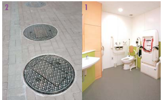
1.アリーナ横、校庭の他、各階に多目的トイレを設置。ウォシュレットがついているため、先生にも人気。 2.災害時トイレ用マンホール。断水時には最上階のプールに蓄えられた水が館内トイレに利用できる。
