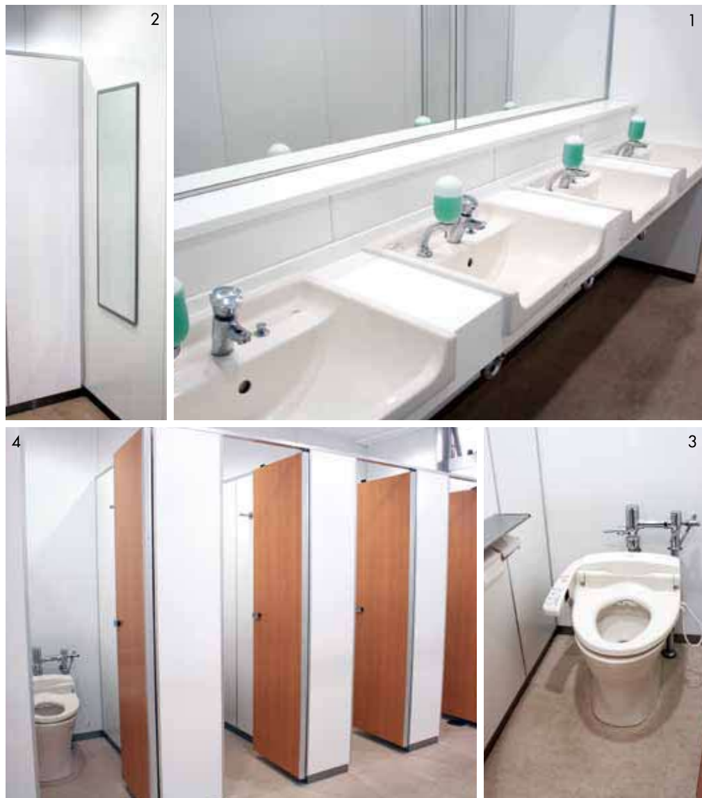
1. 幅広いボウルでしっかり洗え、水はねも少ない洗面器を採用。スポーツ後の洗顔にも便利。 2. 入り口付近に設置された鏡。改修後に行った生徒向けアンケートで「用足し以外のトイレでの行動」をたずねると、64%の生徒が「身だしなみ」と回答。3. ウォシュレット、音姫付きの洋式便器。棚付きの二連紙巻器はポーチ等が置いて便利。4. 改修前には2つしかなかった洋式便器がなんと7つに。
