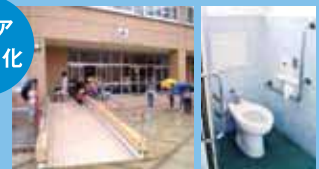
玄関スロープ
