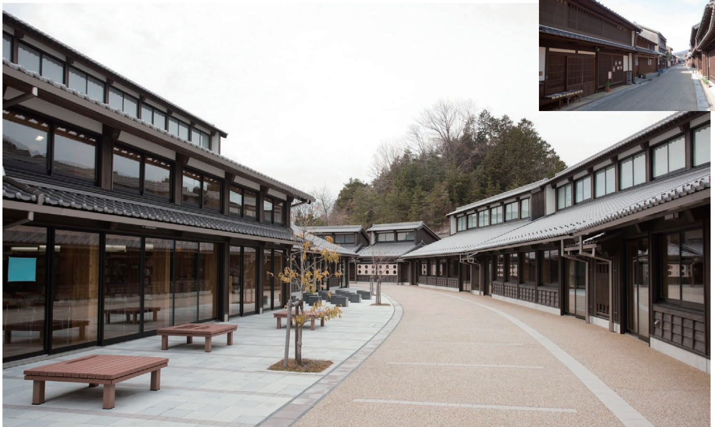
中庭から校舎を望む。右側に普通教室、左側に多目的ホール、メディアセンターなどが配置されており、2つの校舎の間にあるこの中庭は上履きで歩き来できるので、学校活動の中心と位置づけられている。右上写真は閑宿の様子。
