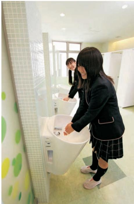
手を差し出すだけで、自動で水が出る壁掛自動洗面器を使用。深めのボウルで、周囲への水はねも防ぐ。
