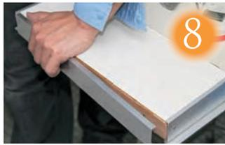
水による劣化を防ぐため、アルミエッジをパネルの下に取り付けます。パネルを支えるサポートも壊れていたら交換します。
