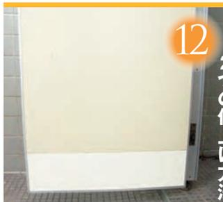
ポリ板の部分的張り替えでは、色違いや突合せ部の隙間ができるため、コーキング材で埋めて仕上げます。補修感を残さないためには、ブースを組み立て直した後(写真12)、化粧フィルムで仕上げます(写真13)。化粧フィルムで表面を覆うことで、新品同様のトイレブースを再現できます。
