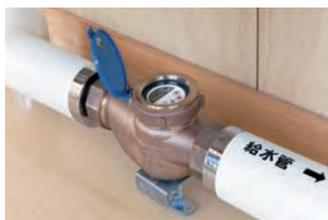
すべての洗面台の下には、誰でも、すぐに水道使用量がチェックできるカウンターが設置してある。
