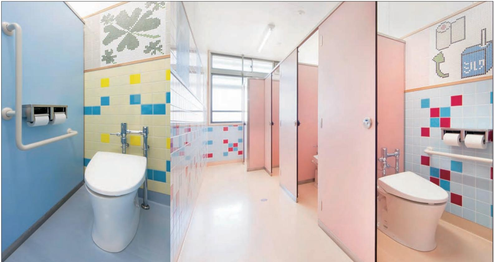
カードゲームでエコの大切さを学び、便器はすべて洗浄水量 6L の節水型便器にした。暖房便座を採用。
