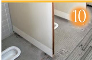
木枠がそのまま使える状態でも、下にアルミエッジを取り付けると耐水性が向上します。アルミエッジをつけない場合でも、ブースを解体してパネル1枚ごとの補修作業となります。
