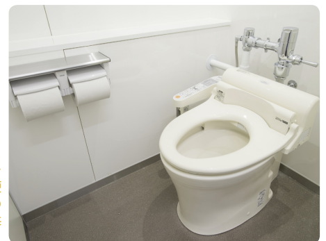
ゆったりしたブース内には、節水型コンパクトタイプの便器。擬音装置付きの温水洗浄便座が改修の標準仕様。
