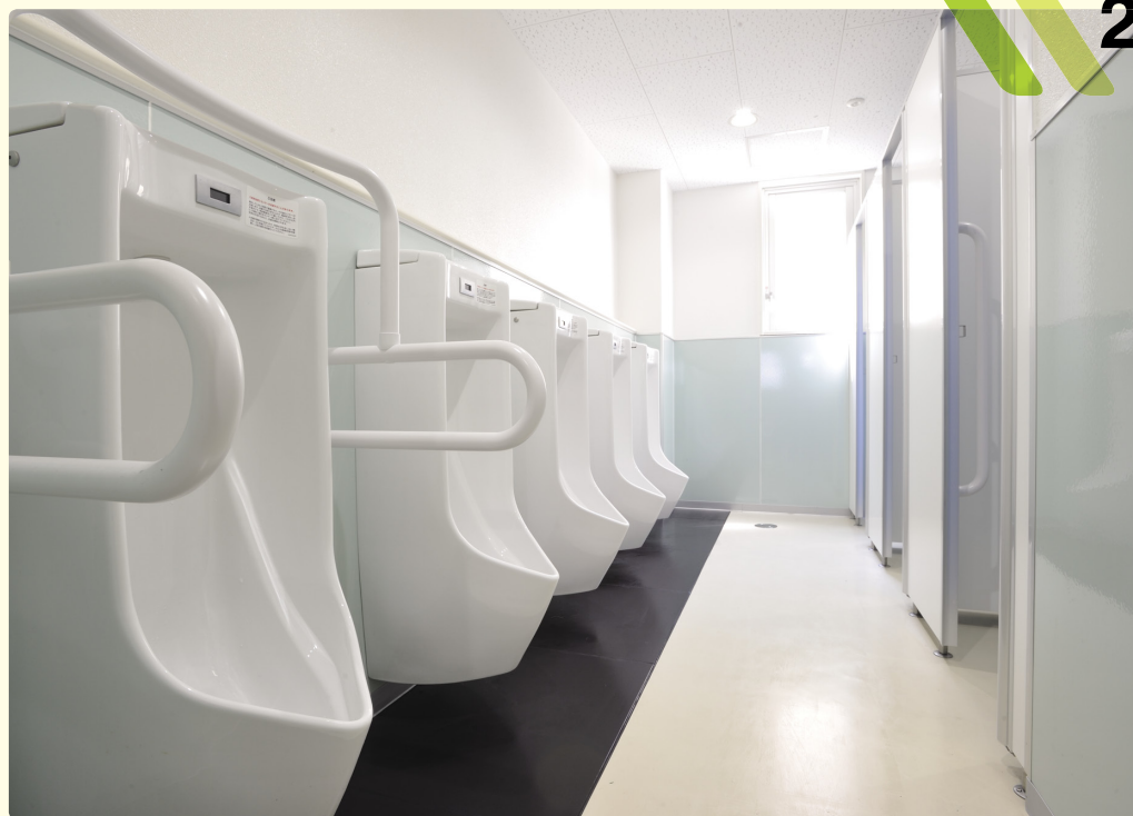
もともとタイルが貼ってあった腰壁部分や小便器の床に、抗ウイルス性や抗菌性、防臭性の高い内装用大型防汚陶板を採用。陶器ならではの防汚性と素材が持つ防臭性で、臭いが抑えられる効果がある。同時に清掃性もアップ。
