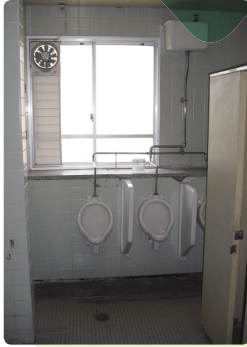
ハイタンク式の小便器。PTAも思わず掃除を申し出た劣悪なトイレ。
