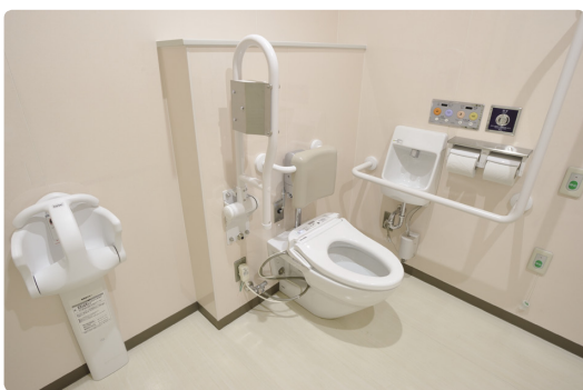
向かい合わせになっていた男女の洗面スペースを多機能トイレに改修。
