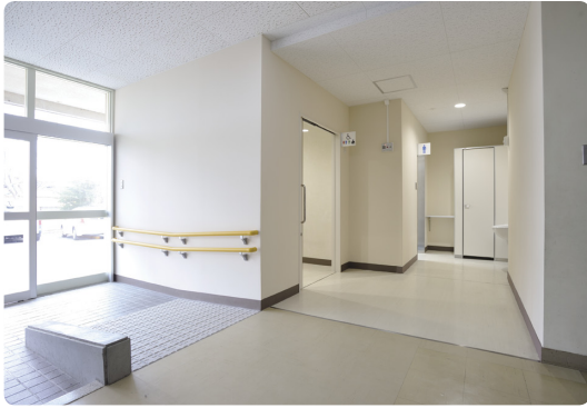
多機能トイレのすぐ横に、そのまま外まで続くスロープを新たに設置。
