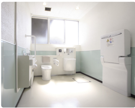
高さ90cmまで内装用防汚陶板を施工した多機能トイレ。ベビシートも設置。
