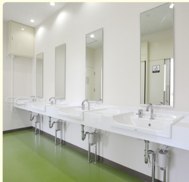
独立した鏡が見やすい手洗い。吐水口空間が広く保てる自動水栓を採用。
