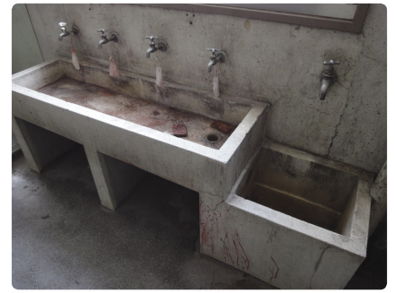
改修前の洗面コーナー。
