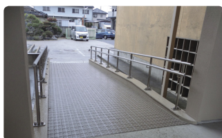
体育館入口に新しく設置されたスロープ。
