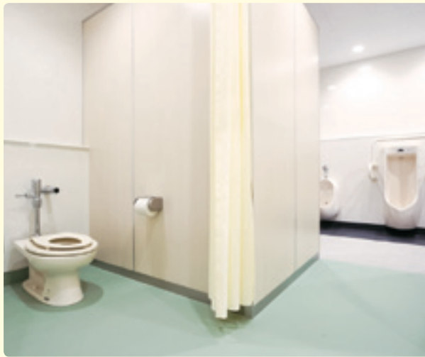
幼児用便座付き大便器を設置した小学部低学年用トイレ。ブースはカーテンでゆるやかに仕切り、介助のしやすさとプライバシーに配慮。
