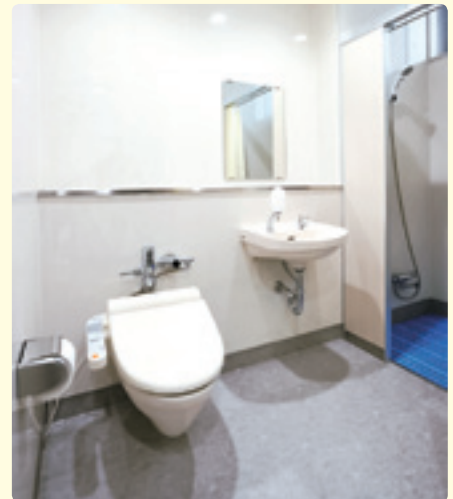
大便器と手洗い、シャワーが一体になったブース。排せつ指導時には、ブース内で一通りの対応が可能。
