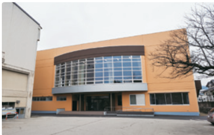
改修後は華やかな紅ウコン色の外観に。正面のガラスには、飛散防止のためのフィルムが貼られた。
