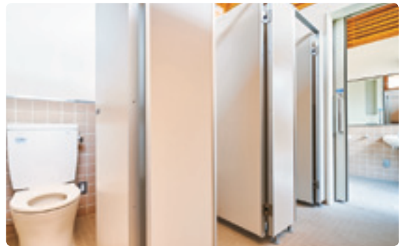
女子トイレ。擬音装置は全ブース標準仕様となっている。
