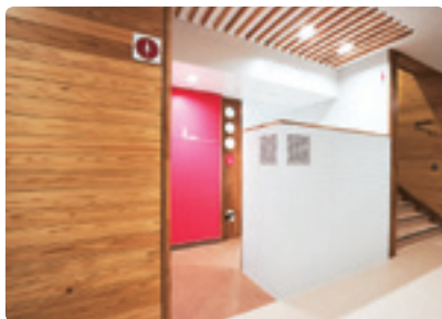
壁には県産の杉を使用。トイレとの仕切りは天井部を広く開けて、開放感のあるつくり。
