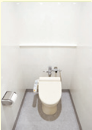
小学部中学年トイレの温水洗浄便座付き大便器。ふたの開け閉め練習も。
