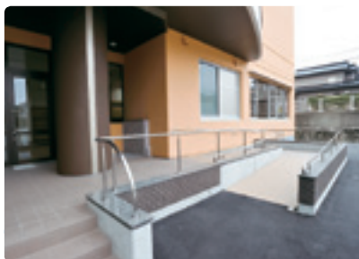
アプローチにスロープを設置。エントランスにあった15cmの段差は底上げをして解消。
