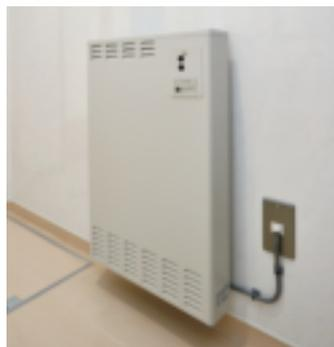
トイレ内はパネルヒーターで暖房。サーモスタットがついており、設定温度を下回ると自動的に稼働する。
