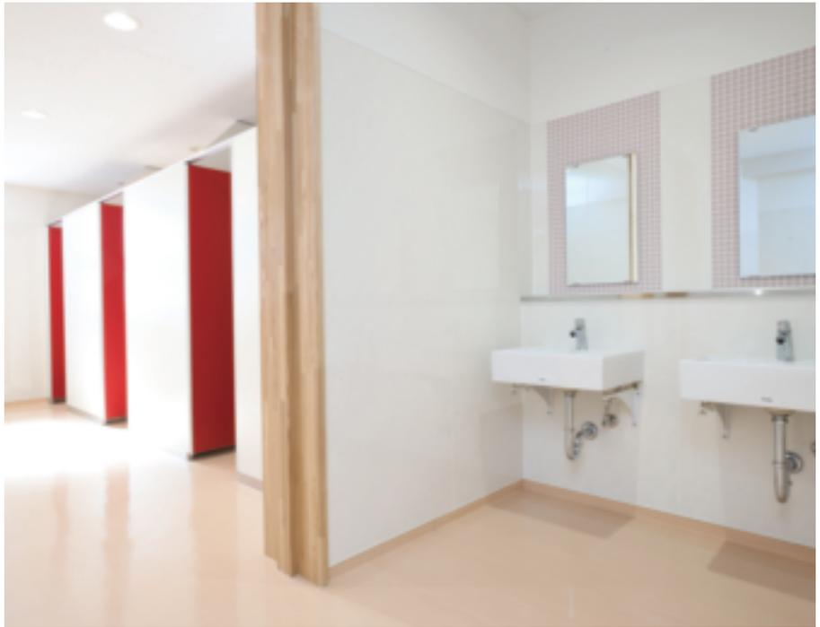
モザイクタイルを使ったかわいらしい女子トイレ。壁は清掃性を重視して汚れを落としやすいキッチンパネルを使用している。
