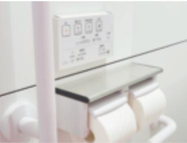
温水洗浄便座のリモコンは、大きくて見やすいボタン配置のものを操作しやすい位置に設置。
