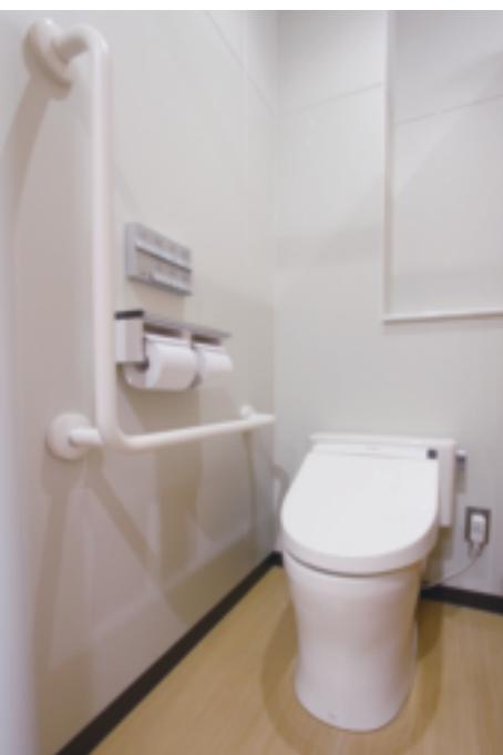
女性職員用トイレの温水洗浄便座。電池交換をしなくていいように、ボタンを押すたびに発電するリモコンを採用。
