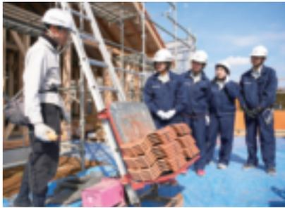
作業着に着替え、まずは昇降機で瓦を屋根の上まで上げる。
