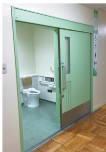
多機能トイレ(だれでもトイレ)を設置してバリアフリー化。
