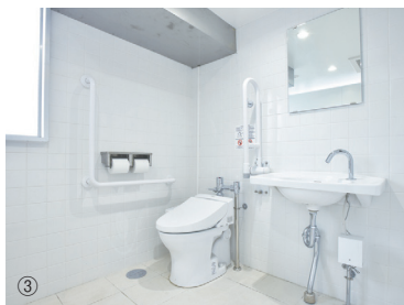
北校舎東側1階特別支援教室近くの男子トイレ。①シャワーブースが設置されている。女子トイレも同様。②右側の扉が車いす使用者用トイレ。ドア枠や仕切り壁にも縦ラインのアクセント。③車いす使用者用トイレは介助がしやすいように広々とした空間を確保。
