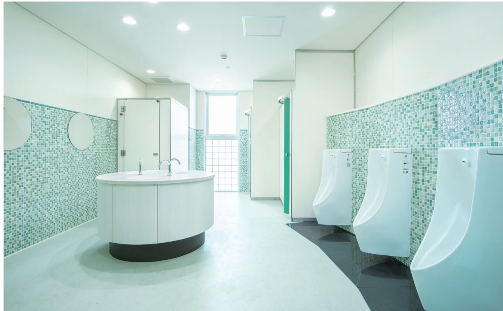
3階男子トイレ。手洗いはコミュニケーションがしやすいようアイランド式に。小便器は自己発電タイプの自動洗浄で省エネにも配慮。
