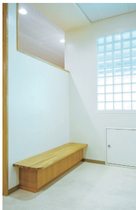
屋上から続く光ダクトが、各階のトイレ前室に自然光を届けている。
