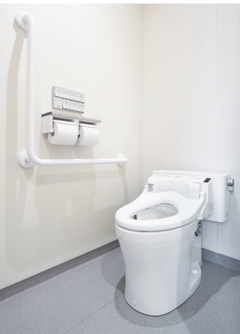
便器は詰まったときにメンテナンスがしやすいよう掃除口付き。操作は押すたびに発電し、その電力でリモコンが作動するタイプを採用。電気工事が不要に。
