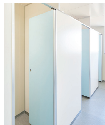
ブースの間仕切りはいたずら防止のため天井まで立ち上げた。
