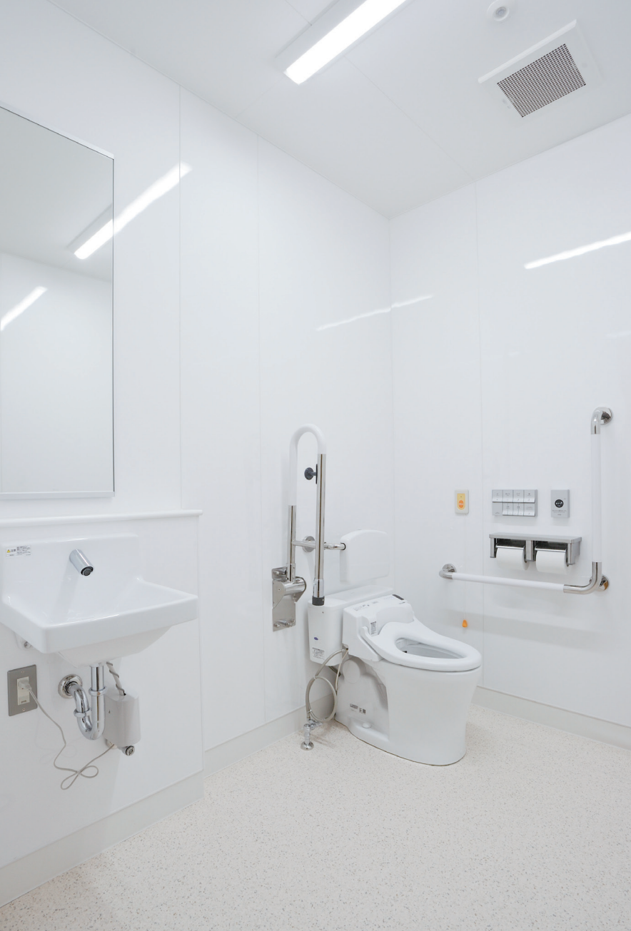
各フロアに設置された「みんなのトイレ」。跳ね上げ手すりとL型手すりの設置で、車いす使用者に配慮している。
