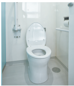
男子トイレのブース。ケガをした生徒が使いやすいように、一部には手すりをつけて。
