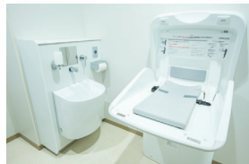
乳児を連れた保護者が使うことを想定し、多機能トイレにはベビシートを設置。
