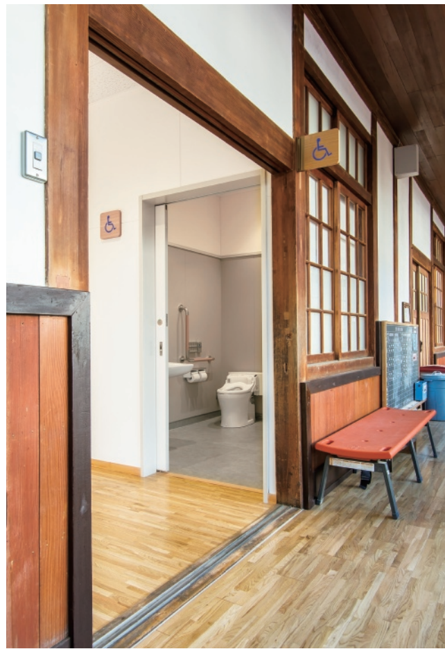
中棟1Fに設置した多機能トイレ。更衣室につながる前室があり、落ち着いて利用できる。
