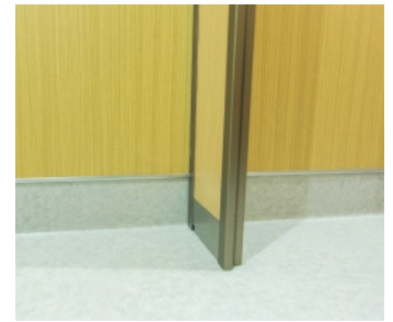
床材は壁面まで立ち上げる施工に。隅にほこりなどがたまりにくくなる。
