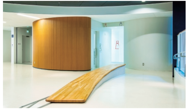
特別教室棟1Fの多機能トイレの前は、車いすも通れるようスロープに。
