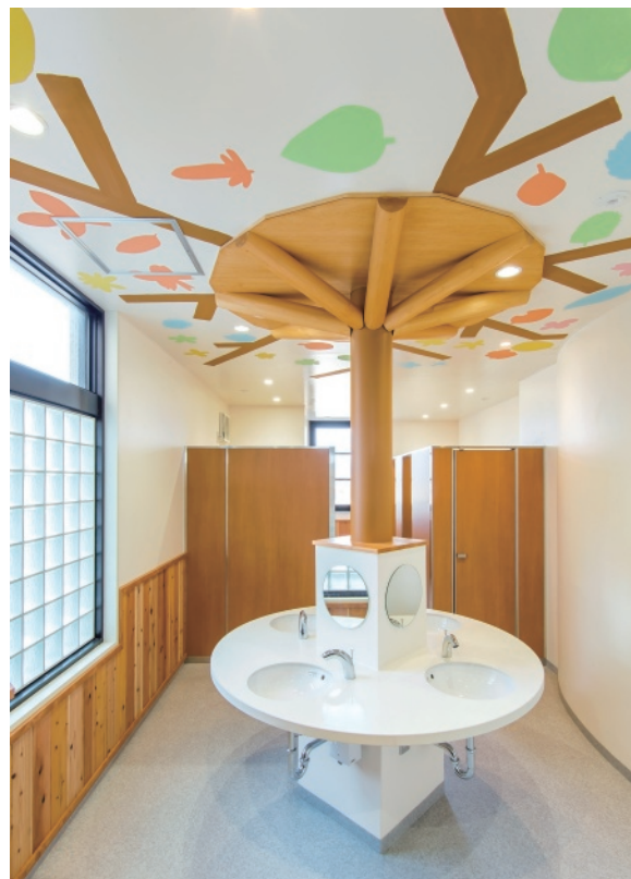
2F女子トイレ。3～4年生が天井の葉っぱの形を考え、大学院生が着色した。中心の柱部分は鉄骨、天井近くの枝は本物の材木できている。
