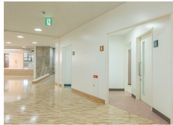
特別教室棟2Fトイレ。入り口はドアレスにするため、クランクにしてプライバシーを確保。地域の人も利用する体育館にも近いため、多機能トイレを設置。
