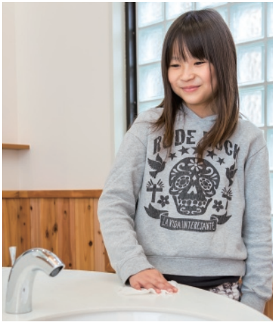
洗面台の水栓金具は、衛生上の観点からすべて非接触の自動水栓に。
