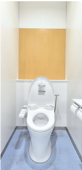
2F男子トイレのブース。トイレ内はメンテナンス性の高い床材を採用している。
