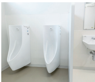
体育館の男子トイレ。掃除がしやすいよう壁掛式の自動洗浄小便器を採用。
