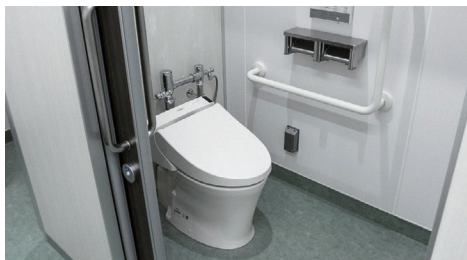
本棟1F男子トイレ。以前清掃用具入れだったスペースをつなげて広めブースを設計。温水洗浄便座を採用した。
