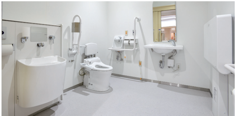
1Fの多機能トイレ。乳幼児連れの保護者に対応できるようベビーチェアとベビーシートを完備。さまざまな人が使えるようオストメイト対応設備を設置。
