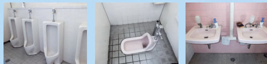
和式で湿式の改修前トイレの様子。 ※出典：神奈川県ホームページ
