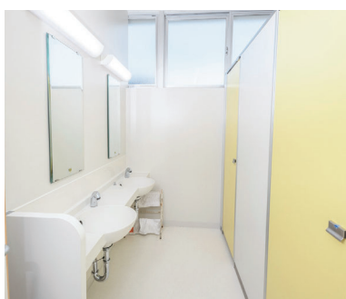
体育館の女子トイレ。災害時の避難所としては、2ブースでは足りないため、校舎の体育館に近い場所に地域住民用トイレを配置した(P.7参照)。
