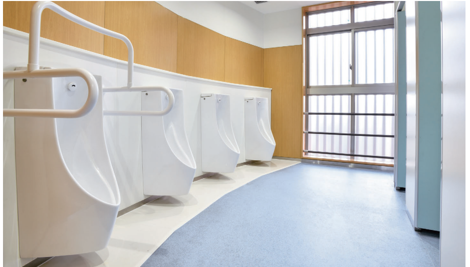
2F男子トイレ。壁掛け式の小便器は自動洗浄小便器を採用。角度をつけ、曲面上に設置した。
