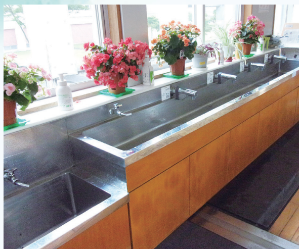
千葉県旭市立海上中学校の改修事例 (取り替え用壁付自動水栓(乾電池)タイプ)
