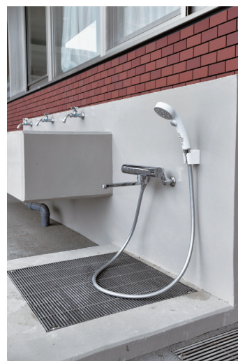
校庭に面した保健室の入り口にシャワーを設置。汚れを落としてから室内に入れる。
