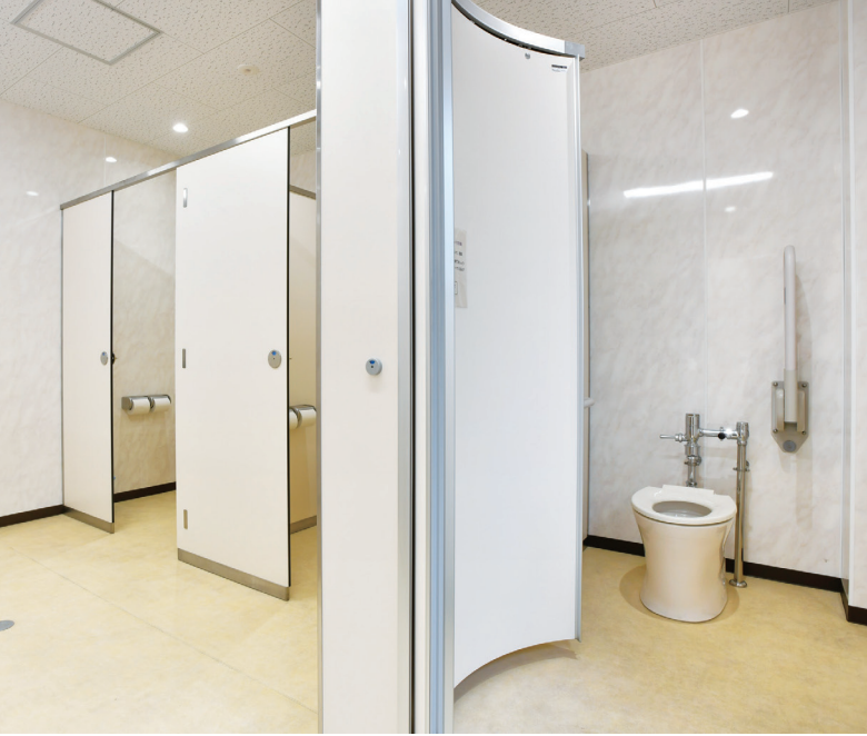
2階女子トイレ。ゆとりブース(手前右)は、弧を描くようにスライドする回転式ドアにし、広いスペースを確保。
