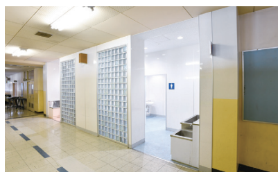
4階トイレ入り口。トイレと廊下はガラスブロックで仕切り、トイレ内への採光にも配慮。
