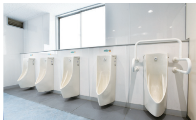
4階男子トイレ。自動洗浄の小便器は壁掛け式にして清掃性を高め、衛生的。
