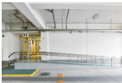
みんなのトイレ設置に伴い、校舎の入り口にスロープを新設。移動のための円滑な経路が確保されている。
