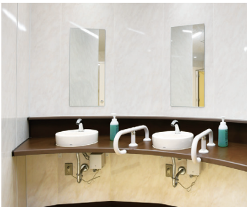
(上)2階女子トイレ。衛生性を考慮し、手洗いは自動水栓化。車いすの人も使いやすいように洗面台の下はスペースを確保。(右)1階トイレ入り口。わかりやすいみんなのトイレのサイン。
