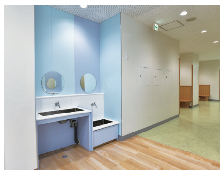
廊下に面した流し。流しの下は十分な空間があり、車いすでも使いやすい。
