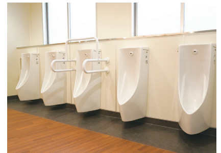
(上)2階男子トイレ。ユニバーサルデザイン配慮として、中央1カ所に小便器用手すりを設置。 (左)2階女子トイレの手洗い。衛生面に配慮し、非接触で使える自動水栓がすべての手洗いに設置されている。
