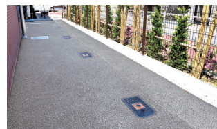
屋外には災害用トイレを設置。
