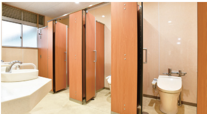
職員女子トイレは温水洗浄便座を設置。中折れ式のドアをはじめ、木目調のブースで温かみのある空間に。
