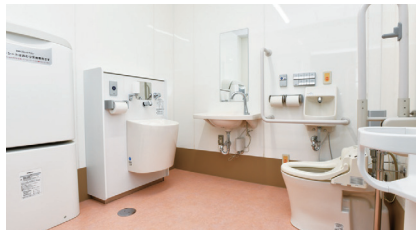
1階みんなのトイレ。オストメイト対応設備に加え、ベビーカーやおむつ交換用の設備も設けられている。
