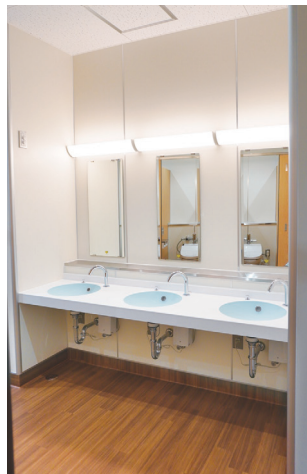
(上)2階男子トイレ。ユニバーサルデザイン配慮として、中央1カ所に小便器用手すりを設置。 (左)2階女子トイレの手洗い。衛生面に配慮し、非接触で使える自動水栓がすべての手洗いに設置されている。
