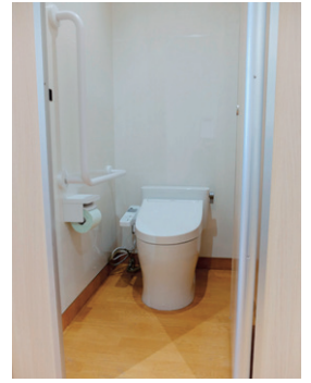
南棟3階東女子トイレ。フラッシュタンク式便器を採用し、ゆとりのあるスペースを実現。
