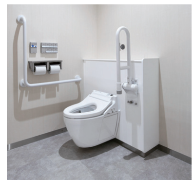
3階分散型女子トイレ内広め個室。けがをしたときを想定し、手すりを設けた。
