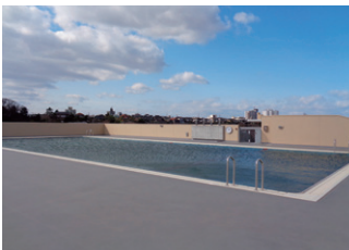
屋上プール。災害時にはマンホールトイレの洗浄水として利用される。
