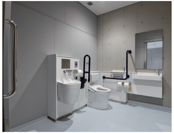
2階バリアフリートイレ。オストメイトに対応した設備の他、手すりも設けた。大便器は温水洗浄便座。
