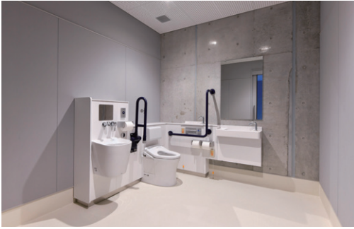
体育館バリアフリートイレ。災害時の利用を考慮し、広さを確保した。オストメイトに配慮した設備や手すりも設置。
