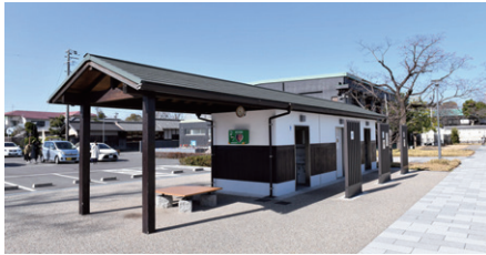
屋外にある公衆トイレ。ベンチの下にはビニールシートが備えられている。非常時、屋根にセットするだけで、仮設テントが完成する。
