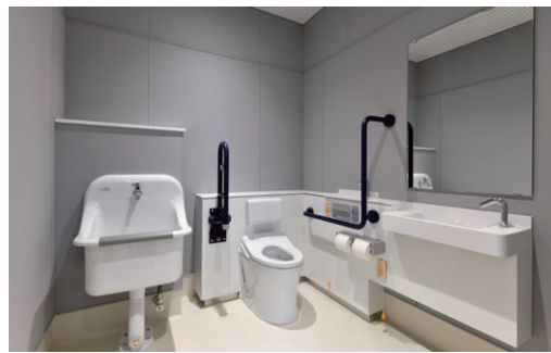
保健室トイレ。同室内に掃除用流しも設けた。
