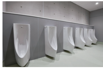
1階男子トイレ。小便器は床の清掃性に優れた壁掛自動洗浄小便器。
