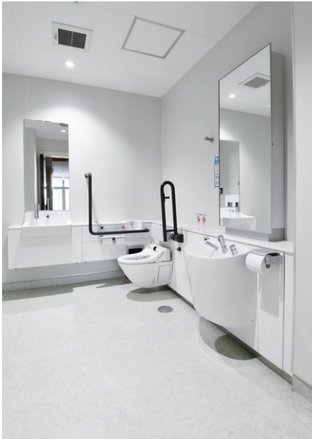
体育館バリアフリートイレ。オストメイトに配慮した設備や手すりを設けた。淡いグレー調で、清潔感を感じられる空間に。
