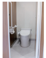
体育館バリアフリートイレ。ゆったりとしたスペースを確保。バリアフリートイレだけでなく、すべての個室に手すりが備えられている。
