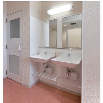
女子トイレ手洗い。感染症対策の観点から自動水栓に。足元には荷物棚も。
