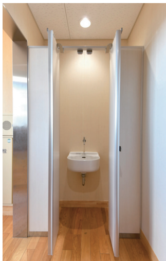
3階分散型男子トイレ内、入り口付近の掃除用流し。男女別トイレ、バリアフリートイレ共に、木目調で統一感のあるデザインに仕上げた。
