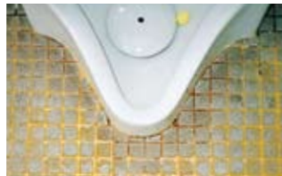
4.小便器取付部
