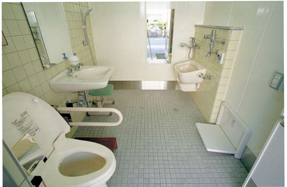
多目的トイレ内部。 オストメイト対応として洗浄シンクとシャワー、着替え用ウィッシングボードが、また子どもの使用には足台も用意されている。
