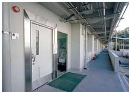
廊下に面した多目的トイレ入口。
