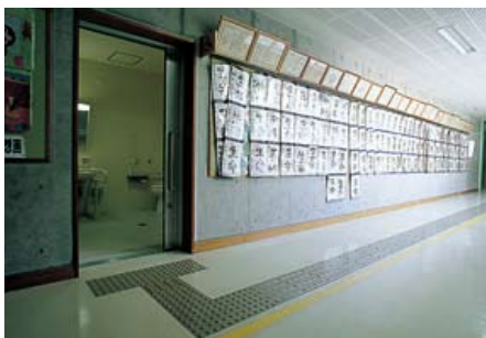
校舎内多目的トイレと点字ブロック。
