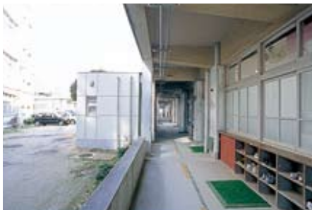
廊下を挟み別棟で増築された多目的トイレ。
