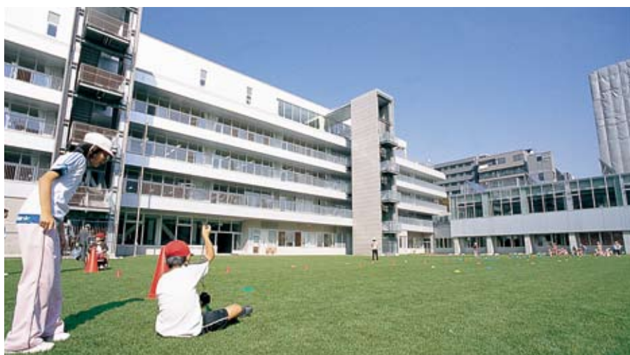
資生館小学校のグラウンド全面に自然芝が敷かれている。右手の低層部は1階が保育園、2階は屋内プール。
