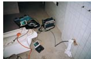
排水管内高圧洗浄
