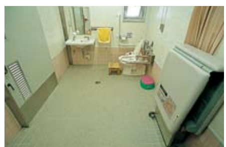
床はタイル貼りでウェット清掃方式が採用されている。
