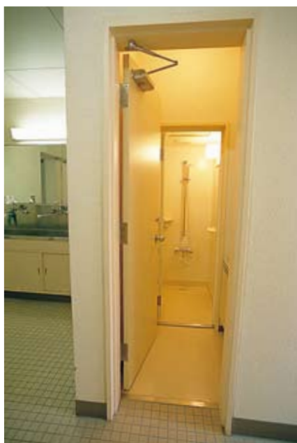
防災棟のシャワールーム。
