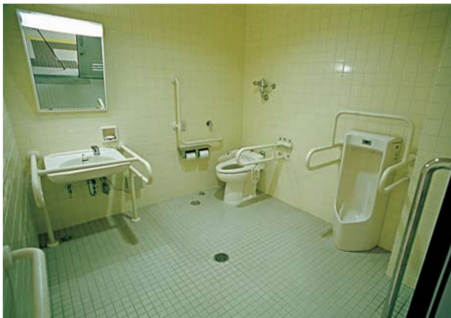
校舎内多目的トイレ内部。清掃方式はウェット。
