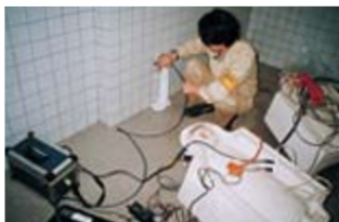
ファイバースコープによる管内調査
