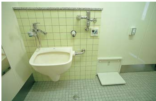
多目的トイレ内部。 オストメイト対応として洗浄シンクとシャワー、着替え用ウィッシングボードが、また子どもの使用には足台も用意されている。
