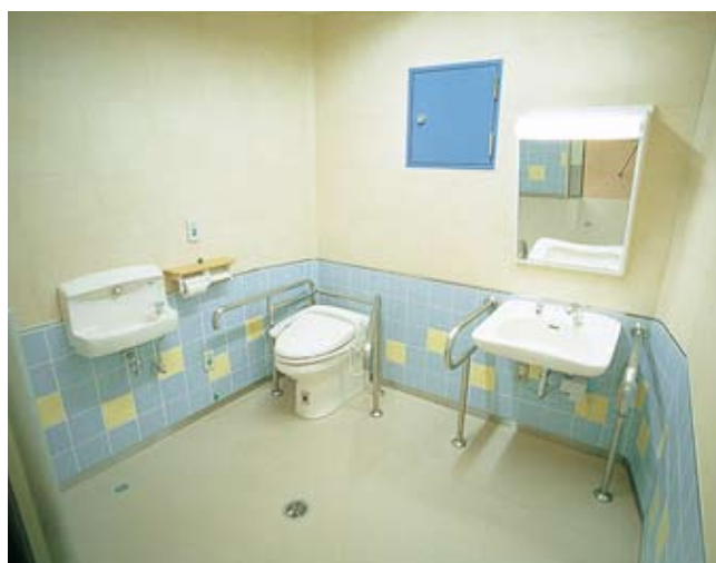
多目的トイレ。(1次改修)
