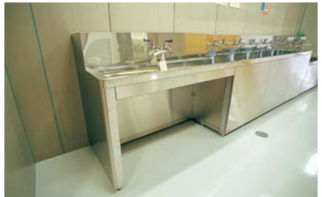
上 男子トイレ内部。 下 トイレ前に設けられた車いす対応のオールステンレス製手洗いコーナー。
