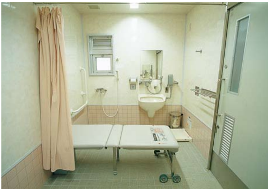
多人数で使う可能性もあるため、カーテンで仕切ることができるように配慮されている。オストメイトにも対応している。
