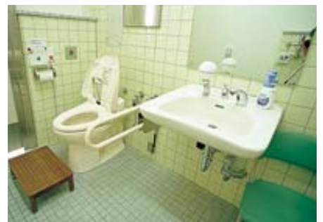
便器と手洗いと足台。
