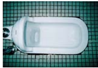
大便器 作業後
