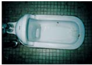
大便器 作業前
