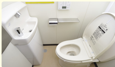
併設された給食センター内の給食従事者専用トイレも、このとき一緒に改修された。コンパクトな手洗いや器が設置されている。
