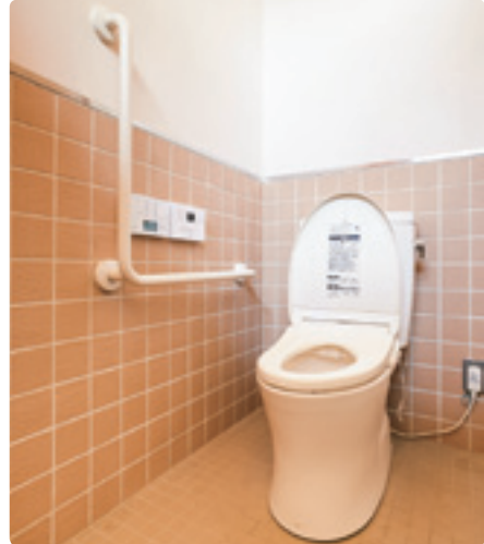
女子トイレは1ブースのみ、簡単な介助ができるスペースが確保され、きれいな除菌水で便器のボウル面を洗う温水洗浄便座を導入。
