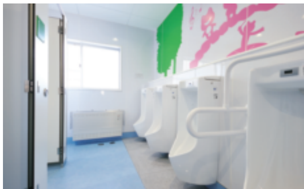
自動洗浄小便器で衛生面に配慮。ここでもパネルヒーターは標準仕様。
