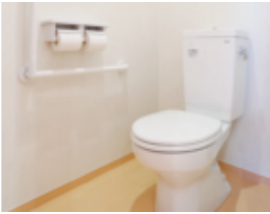
大便器は家庭にあわせて全洋式化。高架水槽方式から直圧式へ配管を変更したため、タンク式を採用。
