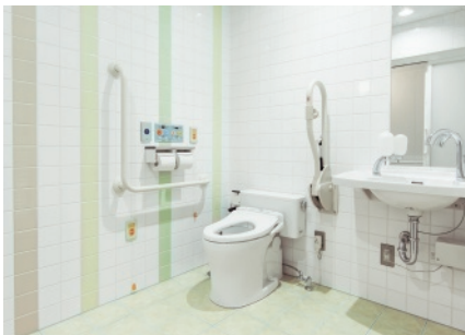
支援教室内トイレ。バリアフリー化が図られ、車いす利用者にとって快適な多機能トイレとなっている。特別教室棟にはエレベーターも設置。
