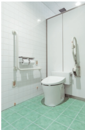
普通教室棟2F男子トイレ。トイレの中には男女それぞれに広めトイレを設置。
