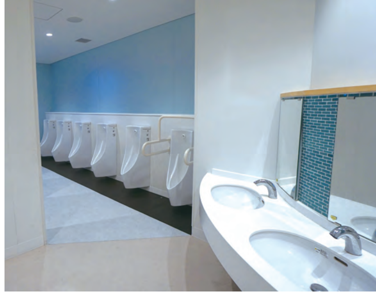
(上)2階南男子トイレ。小便器下の床には汚垂れ石を、手前の小便器には手すりを設置した。 (左)2階南バリアフリートイレ。バリアフリートイレは校舎棟の1・2・3階と体育館に設置されている。
