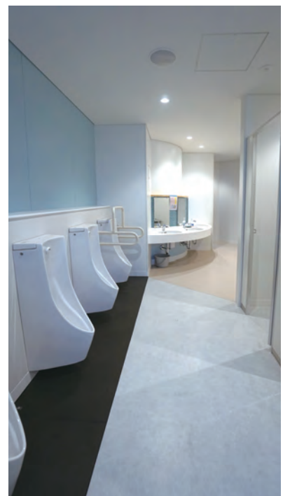
2階南男子トイレ。小便器は床の清掃性に優れた低リップタイプの壁掛自動洗浄小便器を採用。
