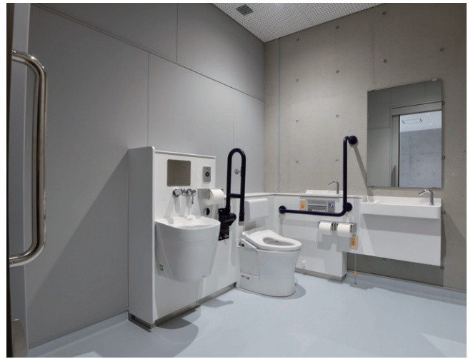
2階バリアフリートイレ。オストメイトに対応した設備の他、手すりも設けた。大便器は温水洗浄便座。
