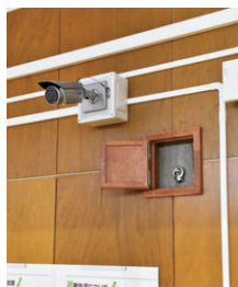
防犯カメラと、ビニールカーテンで仕切る際に利用する金具。
