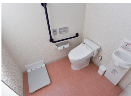
女子トイレ個室。ベビーチェアとフィッティングボードの他、手すりを備えた。大便器はすべて温水洗浄便座。
