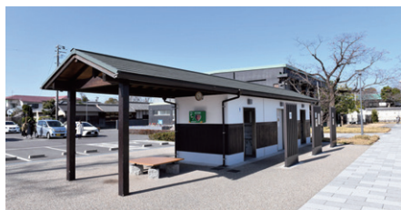
屋外にある公衆トイレ。ベンチの下にはビニールシートが備えられている。非常時、屋根にセットするだけで、仮設テントが完成する。
