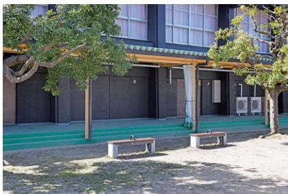
ベンチにも仕掛けが施されている。カバーを外せば、災害時の炊き出し用かまどに早変わり。
