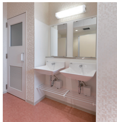
女子トイレ手洗い。感染症対策の観点から自動水栓に。足元には荷物棚も。
